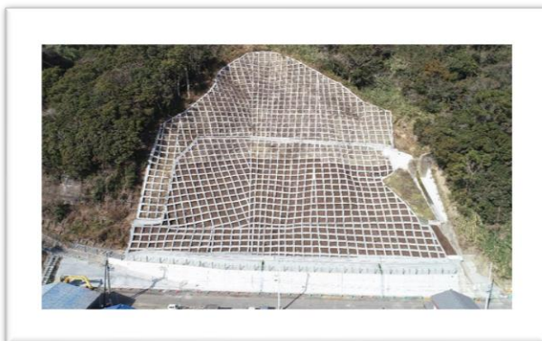
高知県宿毛市大島 大島林地荒廃防止施設災害復旧工事 当社施工
